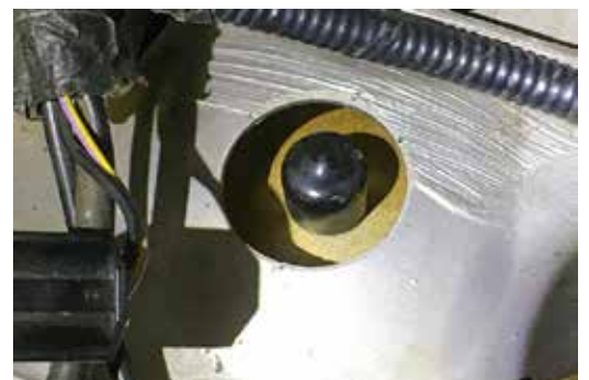
Vi tog upp ett hål ovanför de främre donen för att det skall gå att fylla på gas utan att demontera dem. Hålet på 35 mm gjordes med ett verktyg för att ta upp hål för blandare i diskbänkar. Hålen görs på upphöjningarna för donen, något bakom centrum.
