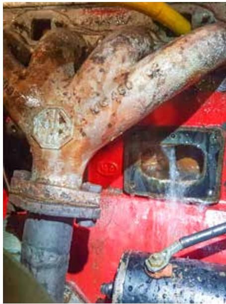
Spolning av kylsystem (och generator).
